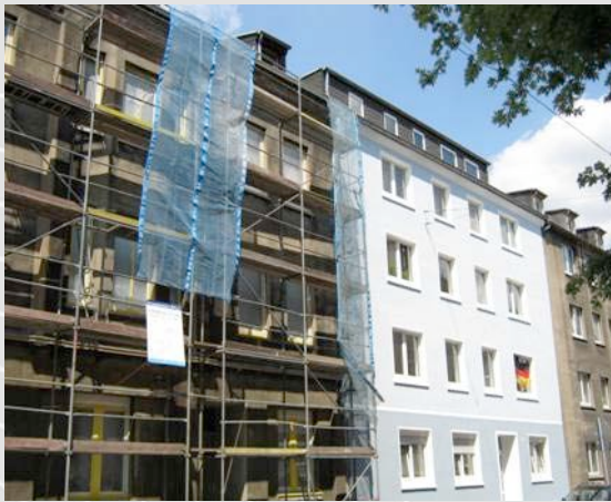
Grenzstraße 167-169: vor Sanierung Fertigstellung
